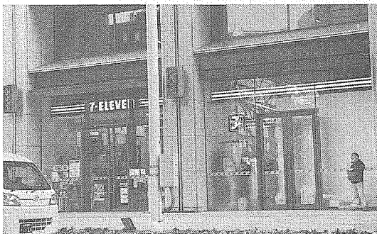
周囲と一体化し街並みに溶け込む店舗
